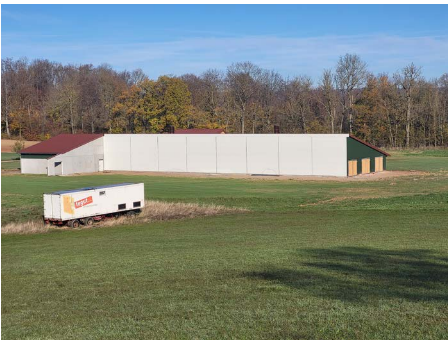
Gem. Willershausen, Flur 1, Flurstück 120/5: Errichtung eines Legehennenstalls, Bauvorhaben ist begonnen (Baugenehmigung aus 2021)
